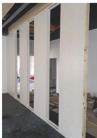
/ Schnelle und saubere Ein-Mann-Montage durch vorgefertigte Konstruktion.
